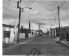
Fotografía IV.9 Av. Alvaro Obregón
