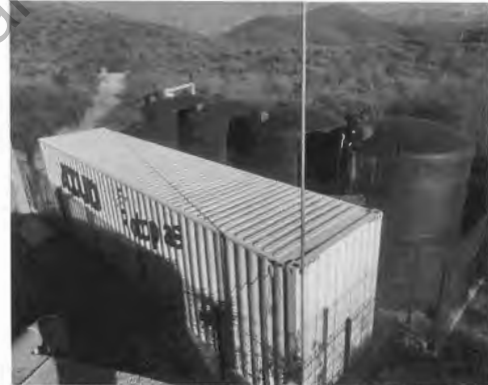
Fotografía 1.1 Planta Tratadora de Aguas Residuales de Banámichi
