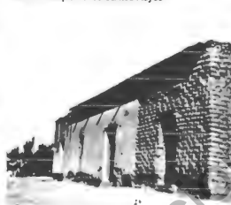
Foto II.6 Casa habitación calle Molino
