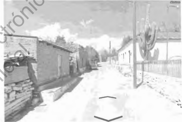
Fotografía IV.2 Vista actual de la Av. Altamirano, derecho de vía de 9 metros
